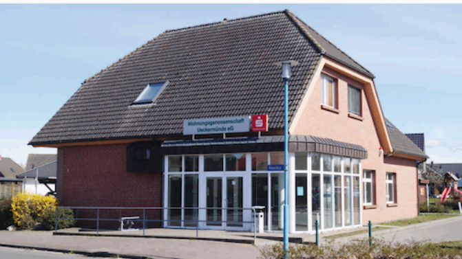
Sitz der Wohnungsgenossenschaft Ueckermünde eG in der Kranichstraße 1.
