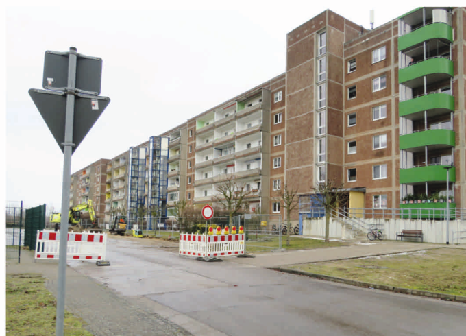
Wegen der Sanierung der Ispenicher Straße werden die Mieter gebeten, auf andere Parkplätze auszuweichen. Fotos: Doreen Schmidt
